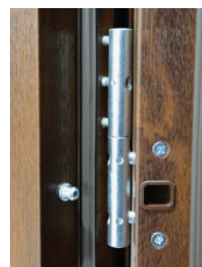
3D panty nastavitelné ve 3 rovinách
