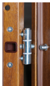
bezpečnostní pant a bezpečnostní hrot proti vypáčení
