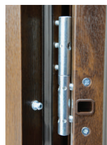
3D panty nastavitelné ve 3 rovinách
