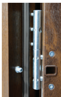
3D panty nastavitelné ve 3 rovinách
