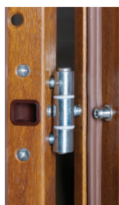
bezpečnostní pant a bezpečnostní hrot proti vypáčení
